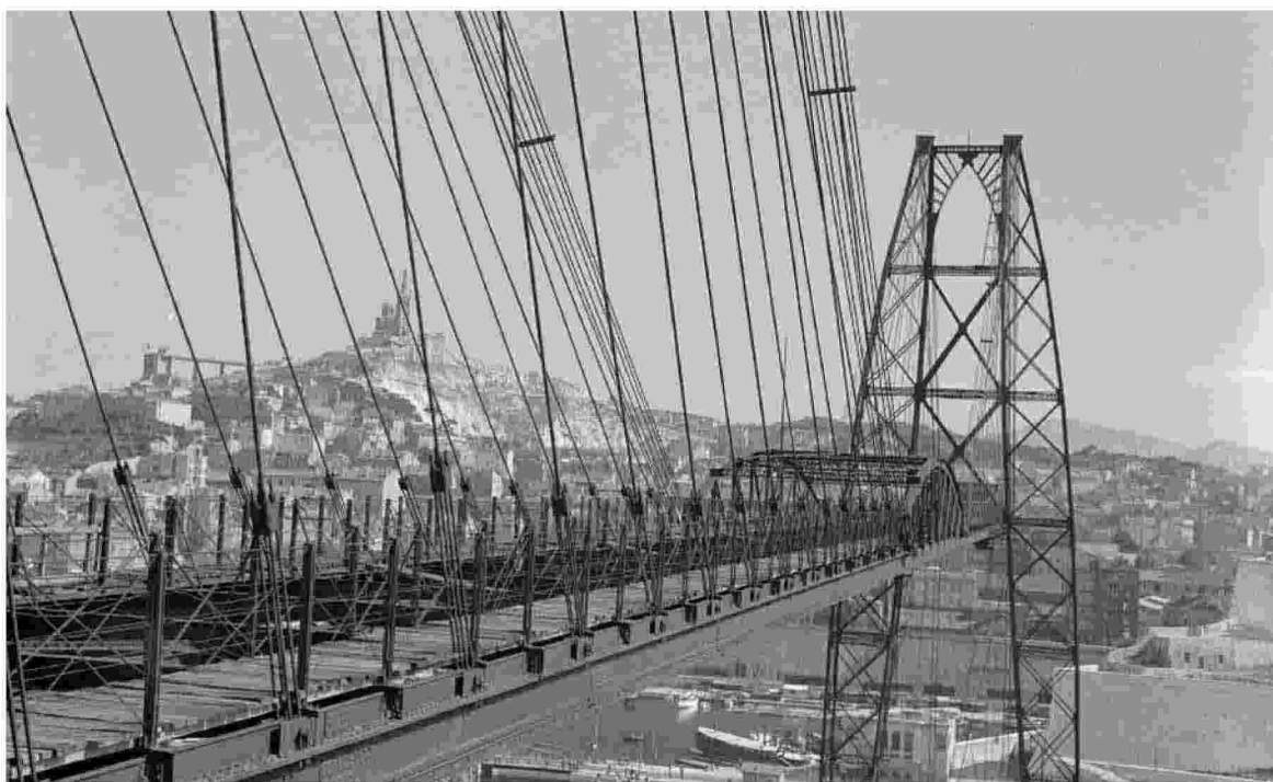
Il Pont Transbordeur di Marsiglia. Una delle architetture emblematiche esaminate da Giedion
